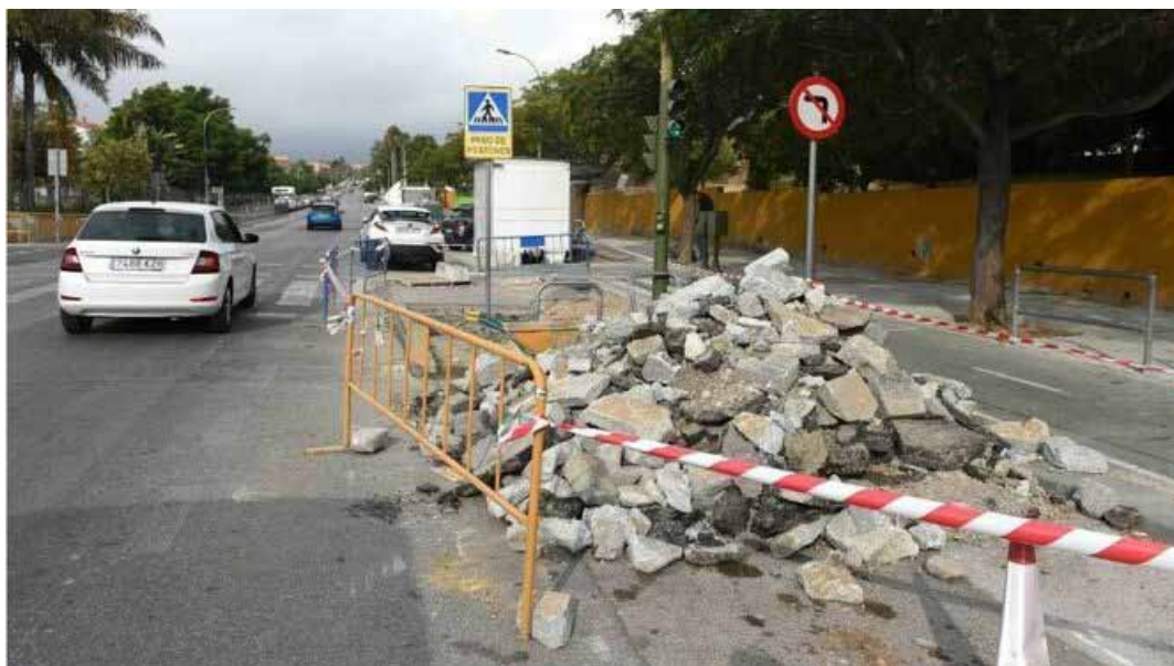
Unas obras en la avenida 28 de febrero de Algeciras.
