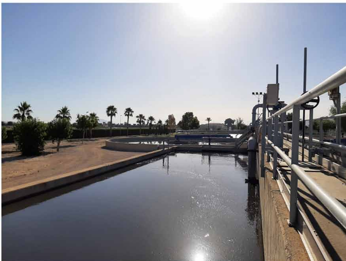
Imagen de una depuradoraAGBAR
