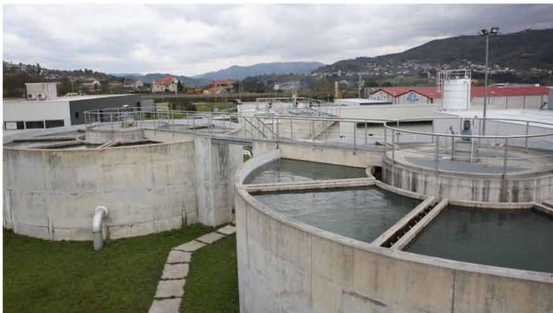
Estación potabilizadora del Concello de Ourense en As Coiñas.
